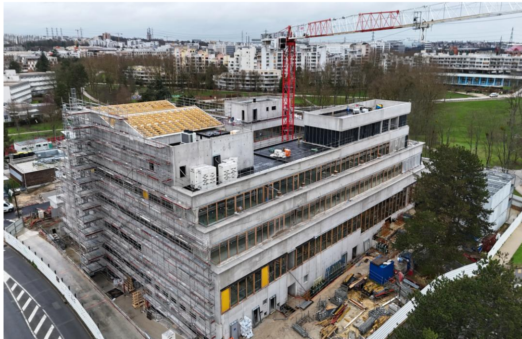
Cergy : Construction de l'école supérieure des Arts
