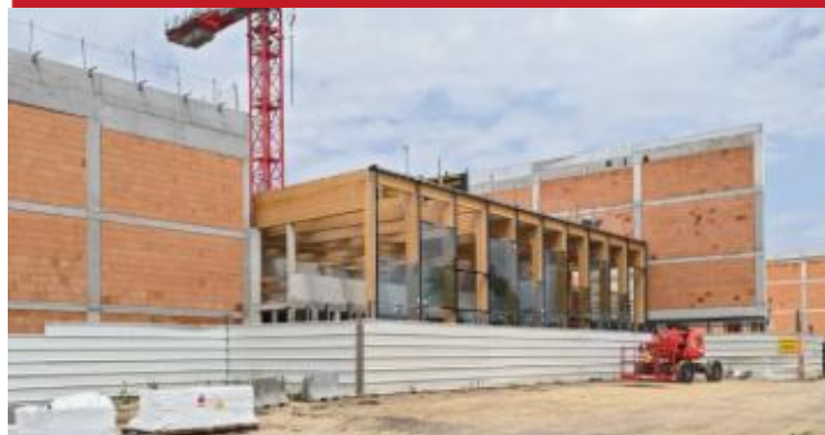
Construction du complexe sportif Didier Vaillant
